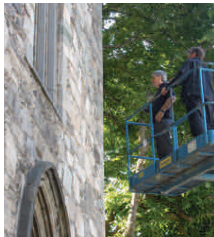
Det ble benyttet lift for å komme tilstrekkelig tett på murverk og kleber i tilstandsvurderingen.
