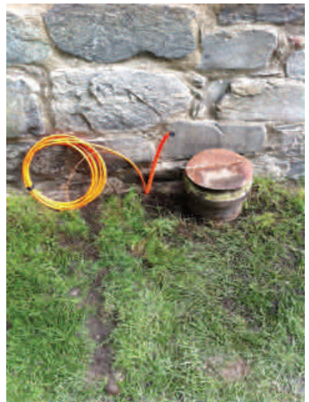
Fiber-alderen har nådd Domkirken. Lufteventilen til høyre sørger for god utlufting av krypkjeller.
