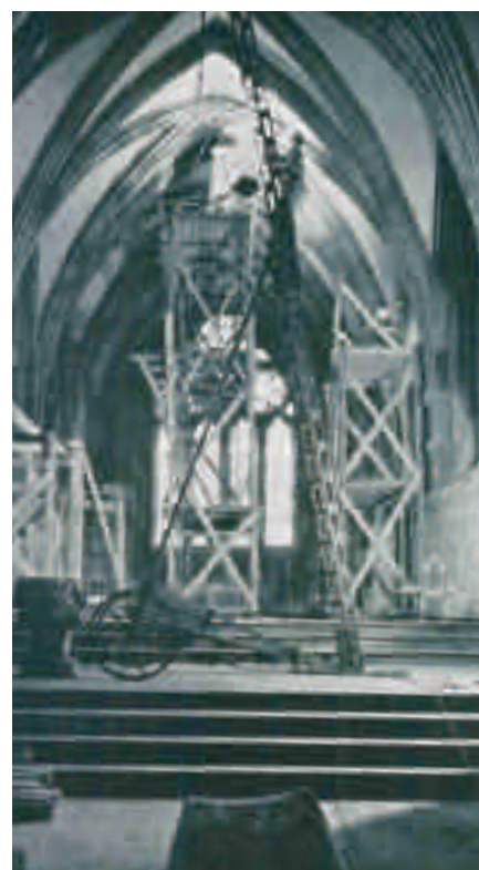
Oppmålingsarbeidet i koret. Foto fra "Domkirken i Stavanger. Kirkebygget i middelalderen" av G. Fischer, 1964
