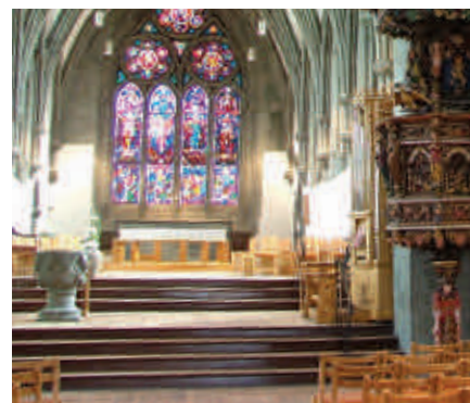
Det er to trapper fra skipet og opp til koret og alteret. Eventuelle løfteanordninger er en krevende prosjekteringsoppgave pga møbleringen i dette området (prekestol, døpefont, kororgel) og fordi det er begrensede muligheter for endringer i bjelkelag og kjeller.
