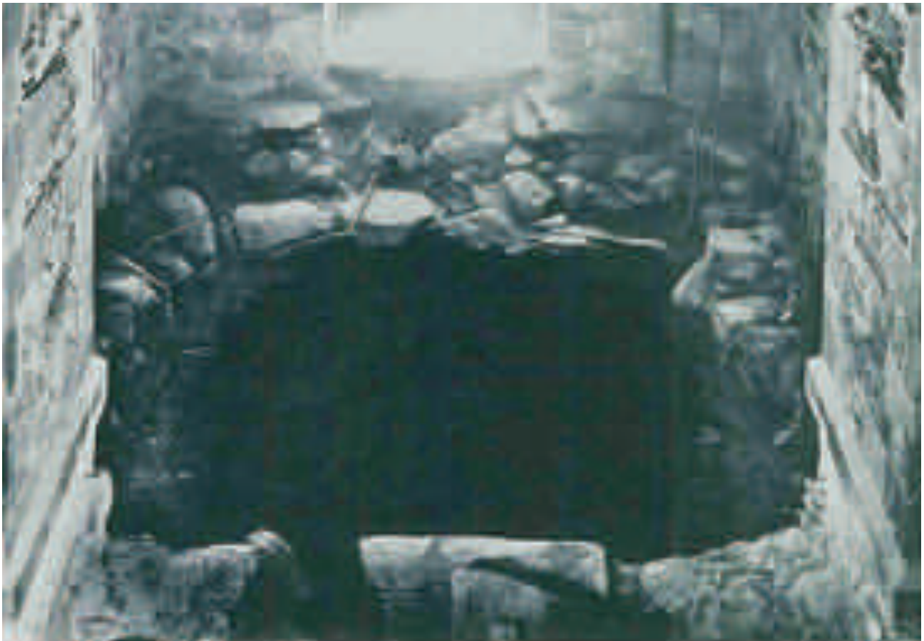
Fischers bygningsarkeologiske undersøkelser avdekket fundamentet for det opprinnelige romanske tårnet innenfor den nåværende vestveggen. Foto fra "Domkirken i Stavanger. Kirkebygget i middelalderen" av G. Fischer, 1964
