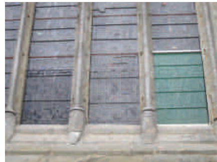
Sikring av glassmaleri i østfronten. Prøve- montasje. Til venstre: svartmalt metallnett. I midten: galvanisert stålnett. Til høyre: refleksfritt glass. Sistnevnte gir et grellt grønnskjær
