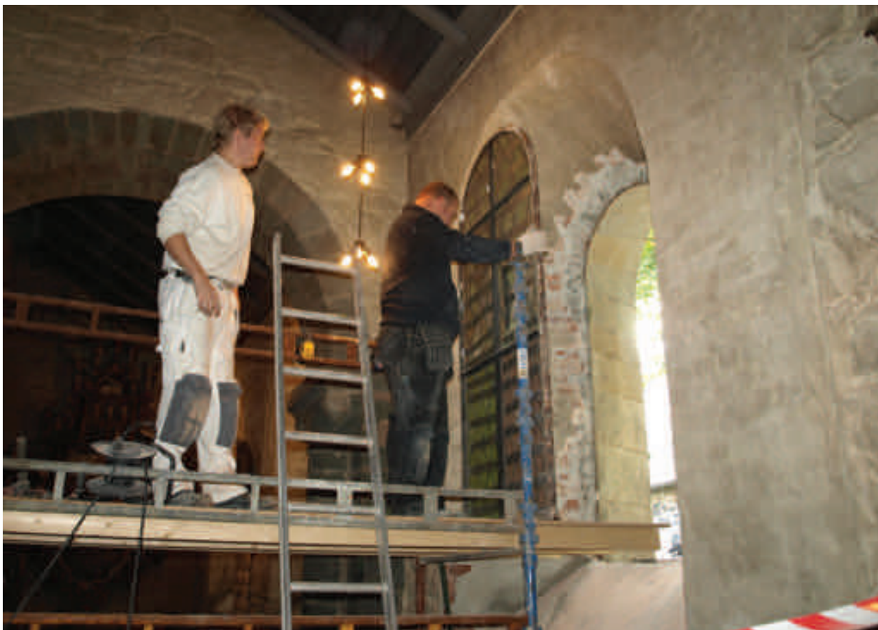
Tilstandsvurdering og prøveuttak av vinduer i skipet i 2010. Prosjektet dannet utgangspunktet for den anbefalte prosedyren rundt restaureringen av de øvrige vinduene i skipet, i tillegg til å gi gode referansetall til kalkylen.
