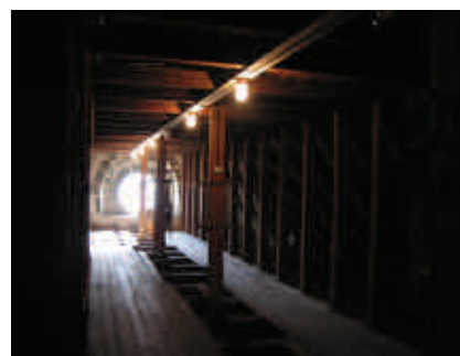
Loftet over koret er dekket med vanntåkeanlegg.
