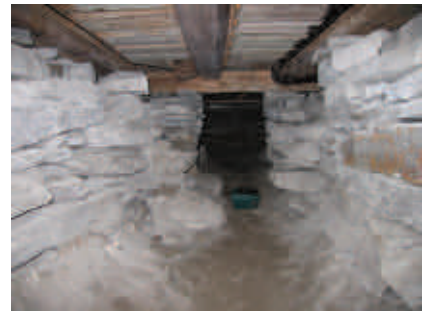
Undergravde tørmurer i krypkjeller- mulig fare for stabiliteten. Det anbefales at det fylles opp med masser.
