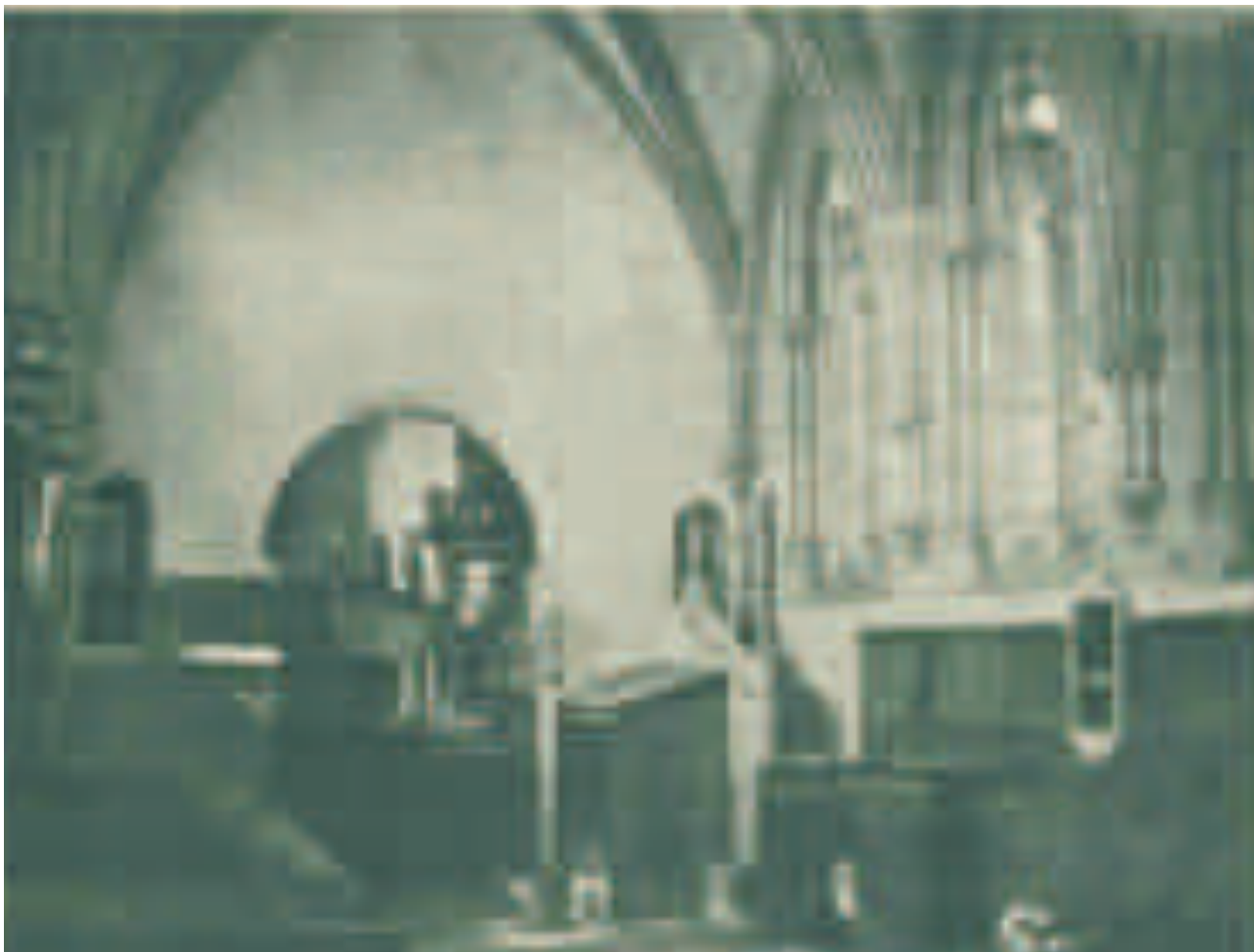
Fra koret inn mot skip. Den opprinnelige bueåpningen var betraktelig mye mindre enn i dag. Hvitkalkingede vegger i både kor og skip. Kleberstein rundt bueåpningene ble også hvitkalket. Foto: Tollinspektør Christensen 1865. Kopiert fra "Stavanger Domkirke. En historisk-arkeologisk utredning", 1933.
