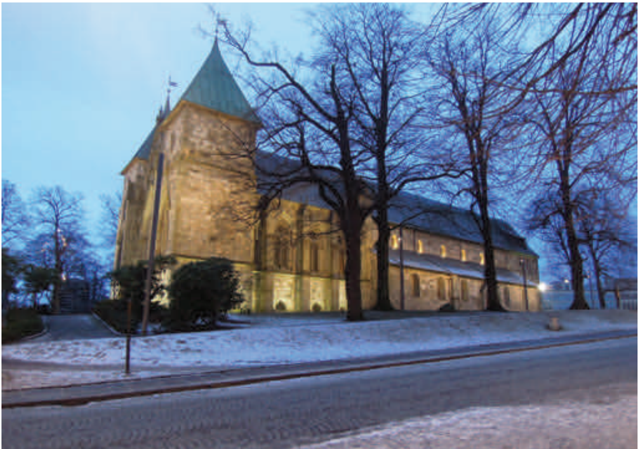
Domkirken en vinterkveld. Den nye utebelysningen rundt kor og østtårn er nedfelt i bakken og lyser opp fasaden. Fordi lyset stoppes av et sprang i murlivet har det den uheldige virkningen at sokkelen blir veldig lys og det skapes en horisontal deling av bygget.
