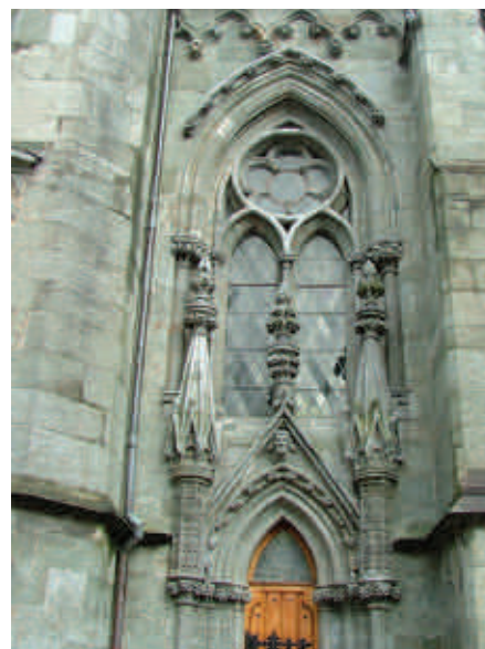
Det er brukt ulike typer kleber i Domkirken. Bispeinngangen over og portalen mot vest under.
