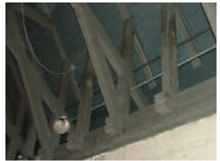
Overgang innvendig tak og toppen av murkronen i skipet vil fortsatt fungere som føringvei for tekniske anlegg. Det anbefales å foreta en komplett utskifting av det elektriske anlegget.
