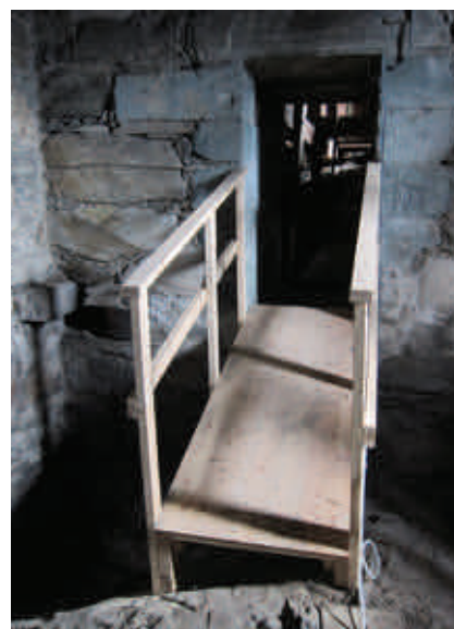
Ny rampe fra korloftet til loft over dåps-sakristiet. Loftene over begge tårn mangler slokkeanlegg.
