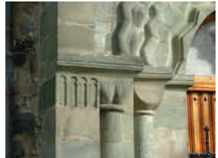
Det romanske skipet er bygget med forbilder fra England. Den første biskopen i Stavanger kom fra Winchester og het Reinald.
