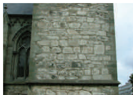
Sørfasade på sørtårnet før restaureringen i 2011-12. Vi ser tydelige rester etter hvitkalking.
