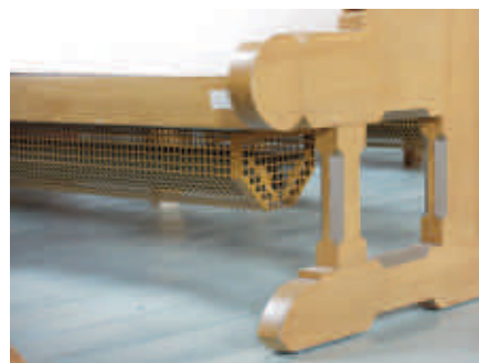
Eksempel på benkevarmere fra Bore kirke montert på historiske benker. På ny-designede benker vil ovnene kunne integreres bedre
