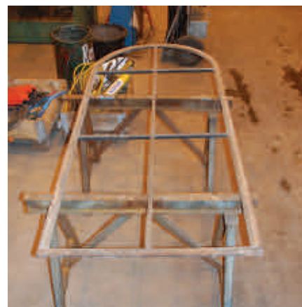
Støpejernsvinduene ble skrappt rene for rust, grunnet med mønje, glasset med blyglass, malt med linoljemaling for til slutt å monteres i vegg.
