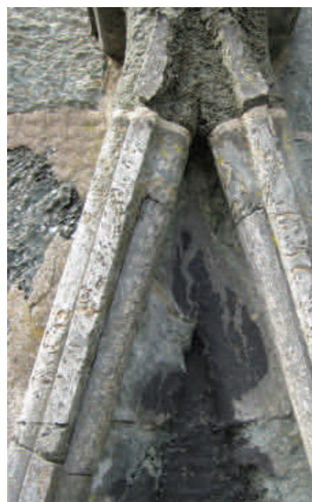
Forvitret kleberstein i Østgavlen.
