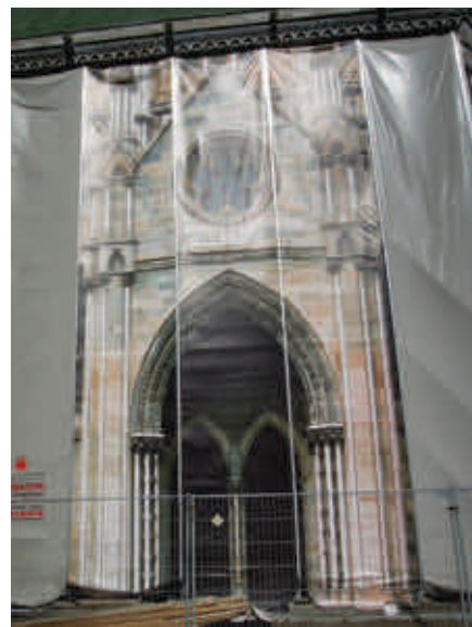
Det vil bli behov for utvendige stillaser rundt Domkirken i lengre perioder. Stillasduken kan utformes på mange fine måter. Her fra Nidarosdomen/ Kongeportalen.
