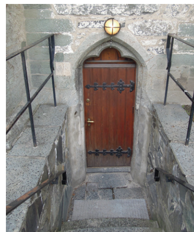
Nedgang til Domkirkekjelleren.
