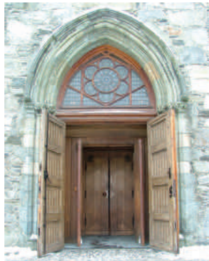
Vindfanget slik det står i dag. Man må gjennom 3 doble, tette dører før man kommer inn i kirken.
